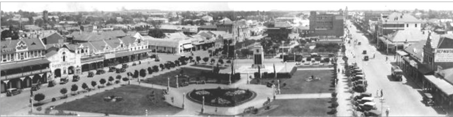
Links is die Cecil-hotel en direk langs aan die Vaudette-teater oorkant Hoffmanplein in die 1930's. (foto: VPAB)
