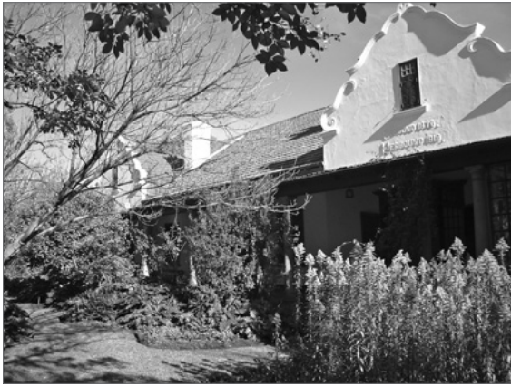
Die nuwe woonhuis op Brandkop wat in 1919 voltooi is. (foto: NM)
